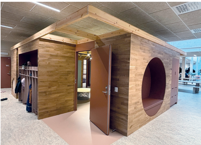
«SFO-boksen» er kledd med eikeparkett fra gulvet i den gamle gym-salen. Skap, dører og vinduer er gjenbruk.
