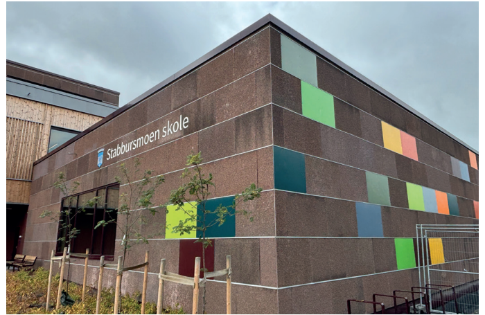
Fasadekledningen på gymsalen består av plater fra den gamle skolen, supplert med fargerike nye plater.
